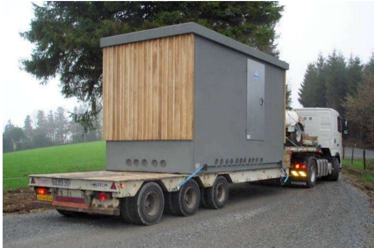
Illustration 12 : Arrivée d'un poste de livraison sur un site éolien
