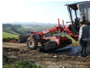
Illustration 21 : Pose du géotextile
