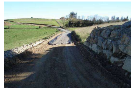
Illustration 22 : Mise en place du gravier
