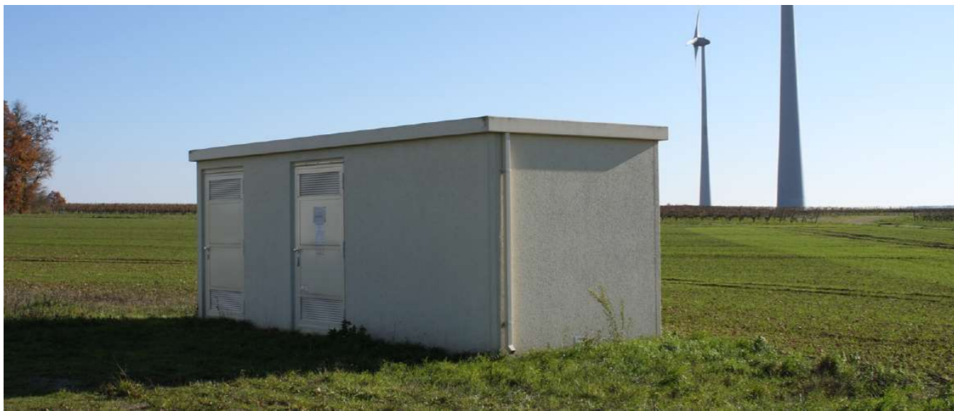
Illustration 13 : Exemple de poste de livraison du parc éolien de Saint-Fraigne (Source : Abies)
